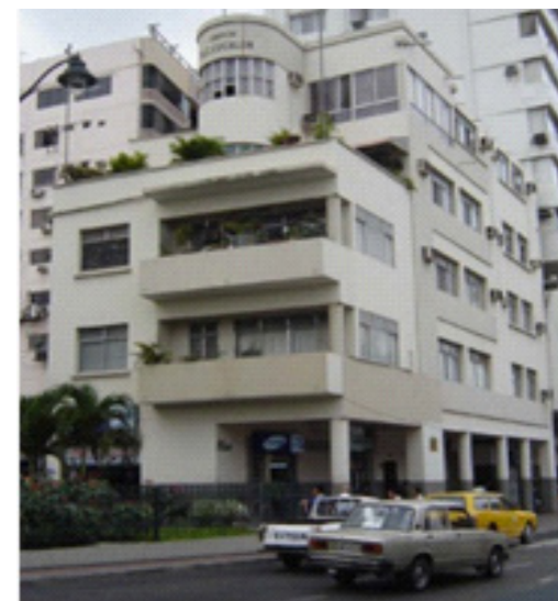
Foto 45. Edificio M. E. Cucalón, 1940
