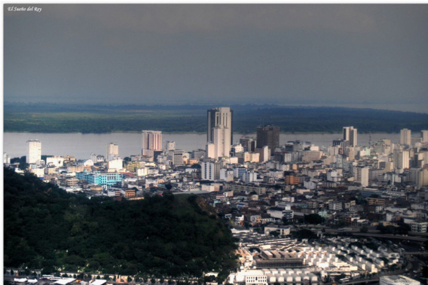
Foto 66. Vista aérea del Área Central
