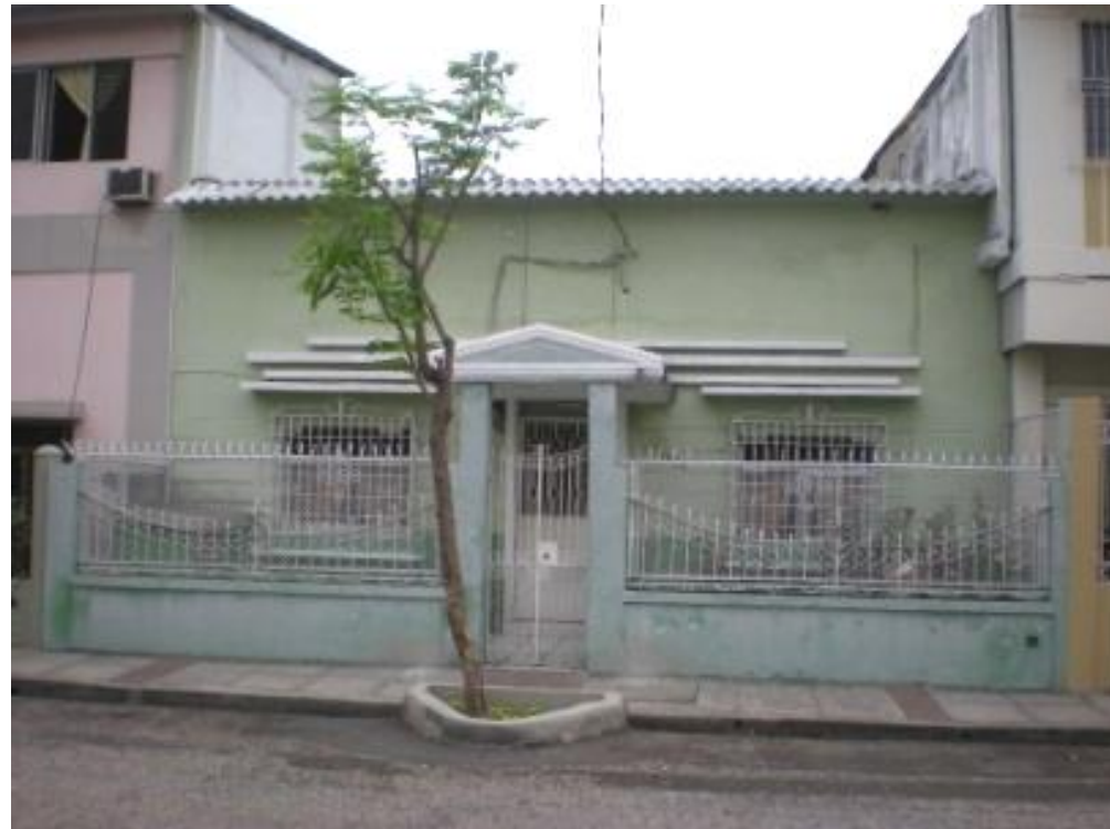
Imagen 34. Luis Vernaza 1534 entre Tulcán y Carchi. Tipología de vivienda, Cubierta asbesto cemento Medianera de 2 ventanas. Foto año 2009
