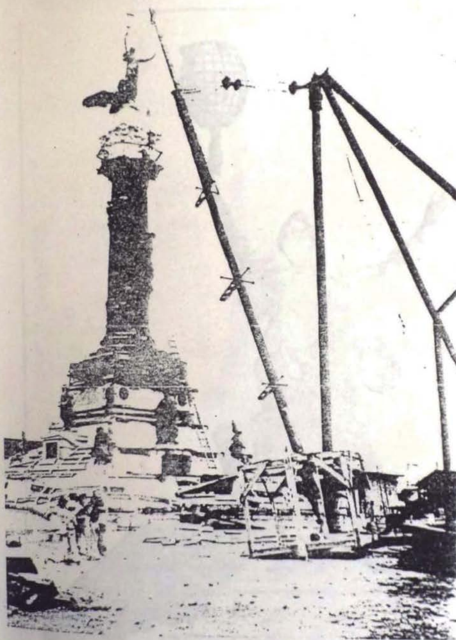
66. Que se coloca sobre la columna.
