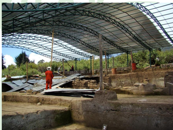
Vista de la colocación del material de cubierta Sitio Ecológico y Arqueológico Rumipamba - Quito Presentación Vicky Domínguez, Curso de Introducción al Patrimonio 2010
