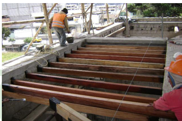
Colocación de nuevas vigas de madera Presentación Irina Godoy, Curso de Introducción al Patrimonio
