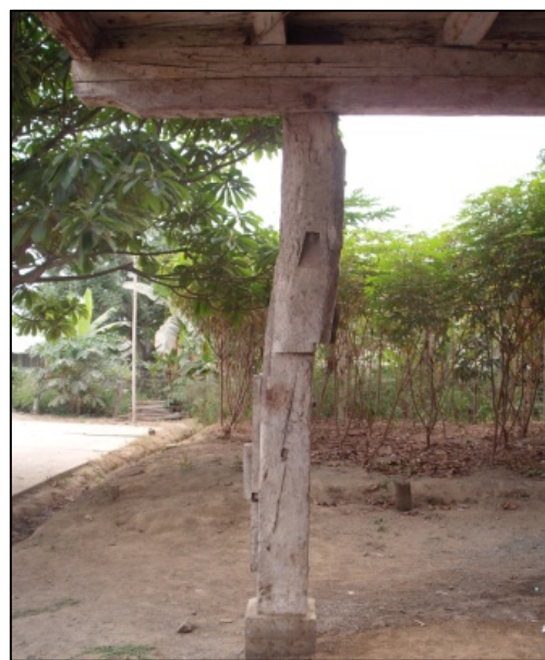
Calado sobre cada cara de las columnas para apuntalamiento (Foto A Santana 2009).
