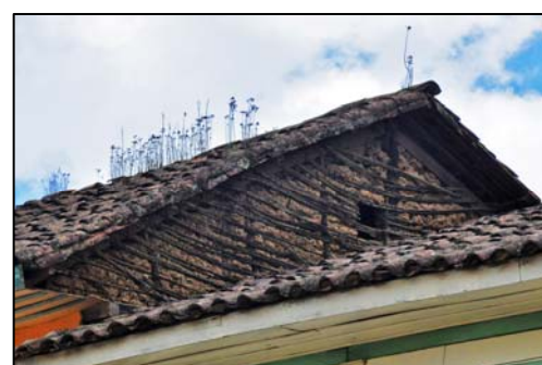
Pared de bahareque utilizada para el cierre superior de los muros contra el techo (Foto JUV 2009)
