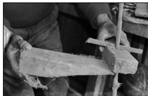
Forma de armar la varilla templadora para sostener la tapialera en su sitio (Foto JUV 2010)
