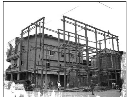
Armado de pórticos estructurales para una casa de 2 plantas altas (A. H. G.).
