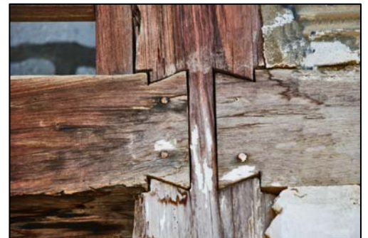
Unión de dos vigas consecutivas con una columna continua por medio de ensambles “cola de milano”
