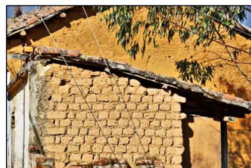
En primer plano, pared construida con adobes sin recubrimiento, más atrás, pared del mismo material ya revestida. (Foto JUV 2009)
