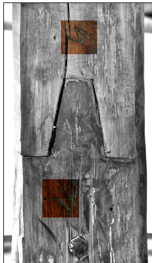
Marcas de cifrado de piezas estructurales, Casa de hacienda La Tropical, Salango, provincia de Manabí (Foto JUV 2009)
