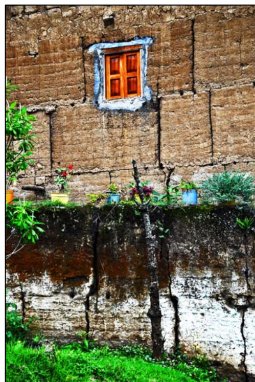
Detalle de casa fabricada con tapial en San Simón, Provincia de Bolívar. (Foto JUV 2009)
