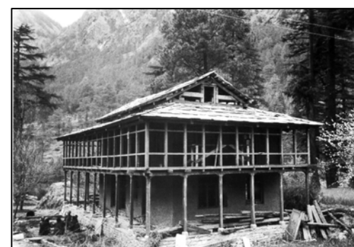
Casa construida a base de vigas y columnas de madera. India (Dwelling 2003).
