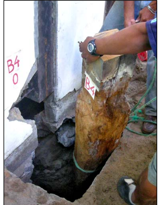
Extracción de un calce para realizar el cambio de tipo de cimentación. Casa de Hacienda La Tropical, Salango, provincia de Manabí (Foto E. Díaz 2009)
