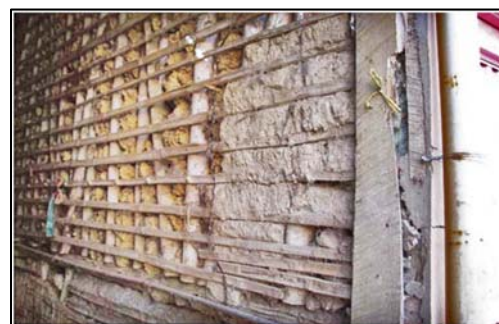
Casa construida con bahareque, Colombia.
