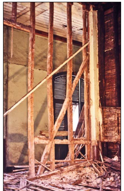
Estructura secundaria de paredes interiores fabricadas con enquinchado de yeso sobre rollizos de mangle, casa Botica del Comercio. (Foto JUV 1995).
