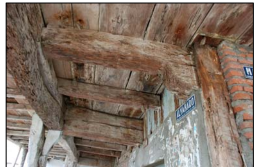
Detalle estructural de fachada de la casa Reyes en Yaguachi (Foto JUV 2008)
