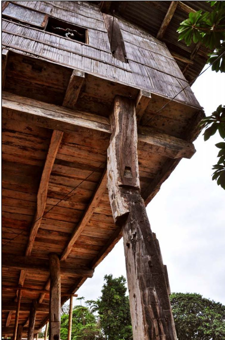
Vista inferior del armado de la estructura principal de piso. Casa de hacienda San Sebastián. (Foto JUV 2009).
