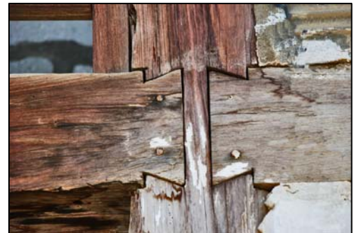
Ensamble de dos vigas sobre una columna continua, mostrando los rebajos de apoyo. (Foto JUV 2007)
