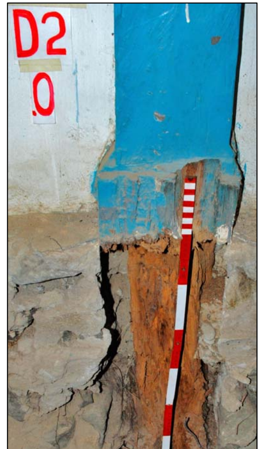
Pérdida de sección en la parte enterrada de un calce. Casa de Hacienda La Tropical (Foto JUV 2009).
