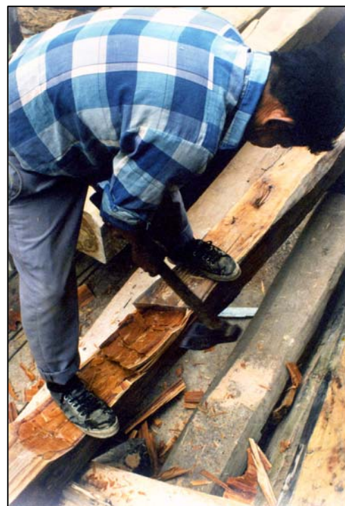
Maestro carpintero labrando un ensamble rayo de Júpiter en la obra “Casa Pintado” del Barrio la Peñas (Foto JUV 2000).
