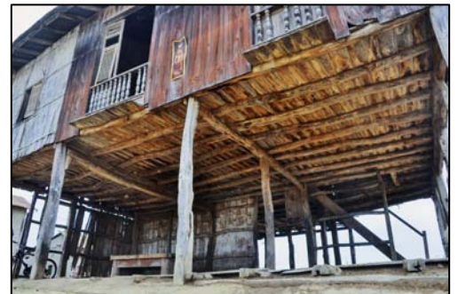
Estructura de piso de una casa en Engunga, península de Santa Elena. (Foto JUV 2009)
